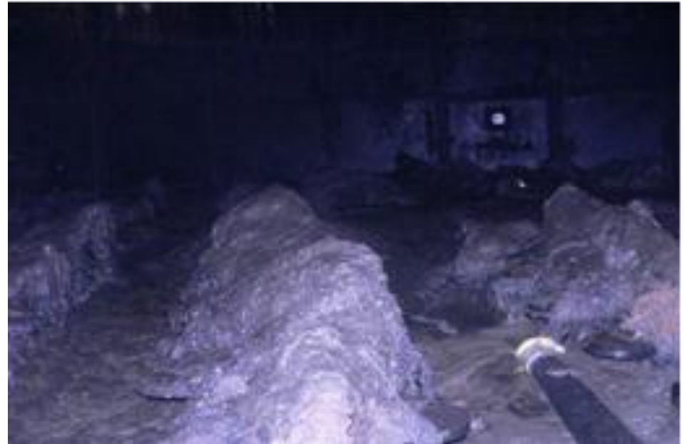
Boden des alten Schlammvorlagebehälters mit sedimentiertem MAP
