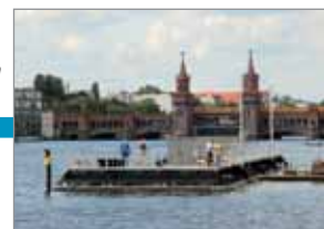
Mischwasserspeicher in der Spree
