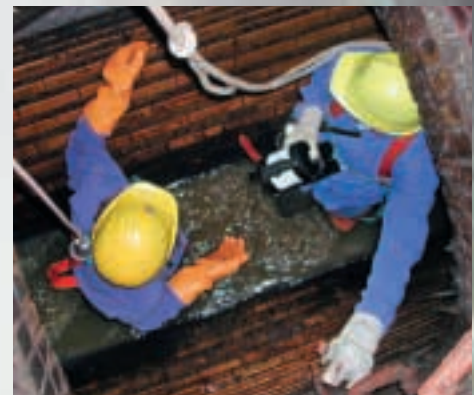
Begehung und Voruntersuchung eines Abwasserkanals
