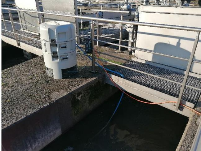
Abbildung 5: Bild eines gekühlten automatischen Probennehmers am Zulauf der Kläranlage Steinhof in Braunschweig.
