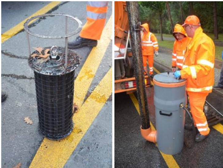
Abbildung 4.10: INNOLET-G Berlin, Filterpatrone und Reinigungsanlage, direkt mit Baggersaugwagen verbunden
