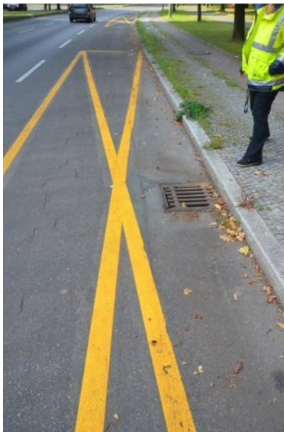
Abbildung 3.8: Flächenmarkierung zur Sicherung der Zugänglichkeit der Straßenabläufe
