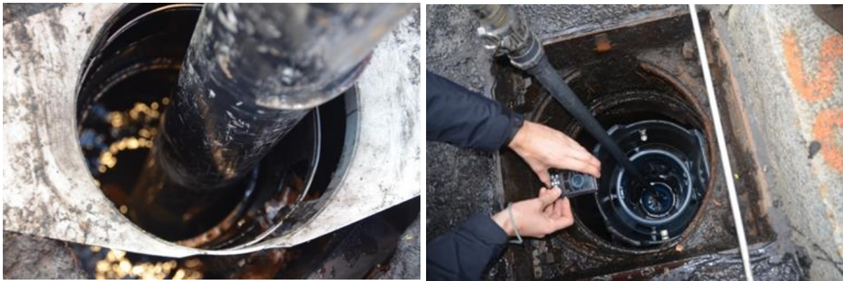
Abbildung 4.6: Standardsaugrüssel DN 150 Baggersaugwagen BSR (links), Reduzierung für Reinigung BUDA VINCA Typ-N auf DN 70 (rechts)
