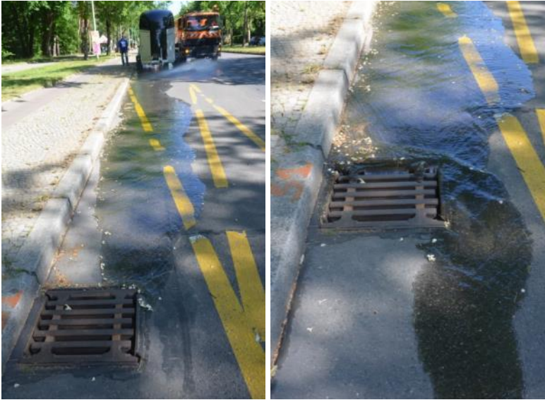
Abbildung 4.4: Anströmung und Umfluss am Straßenablauf
