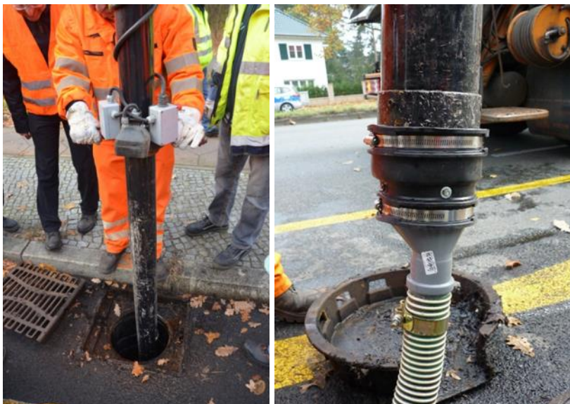
Abbildung 4.7: Standardsaugrüssel DN 150 Baggersaugwagen BSR (links), Reduzierung für Reinigung BUDA VINCA Typ-N auf DN 70 (rechts)
