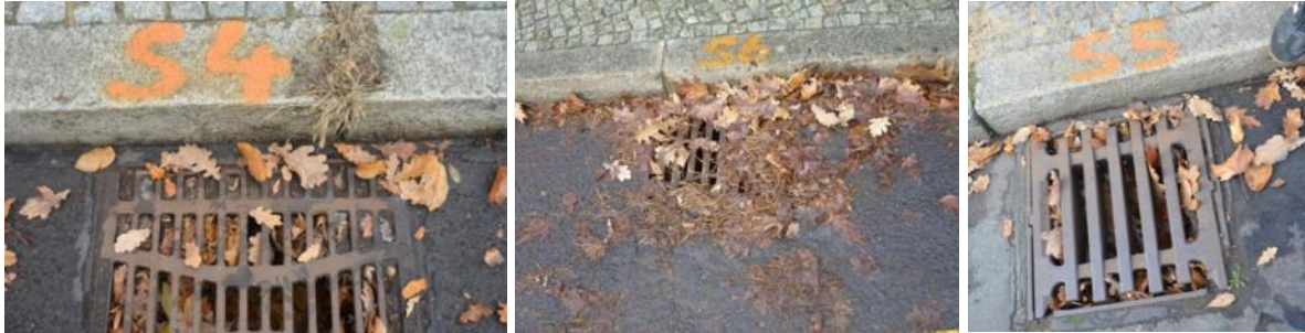
Abbildung 4.2: Eintrag Blätter, Gitterrost
