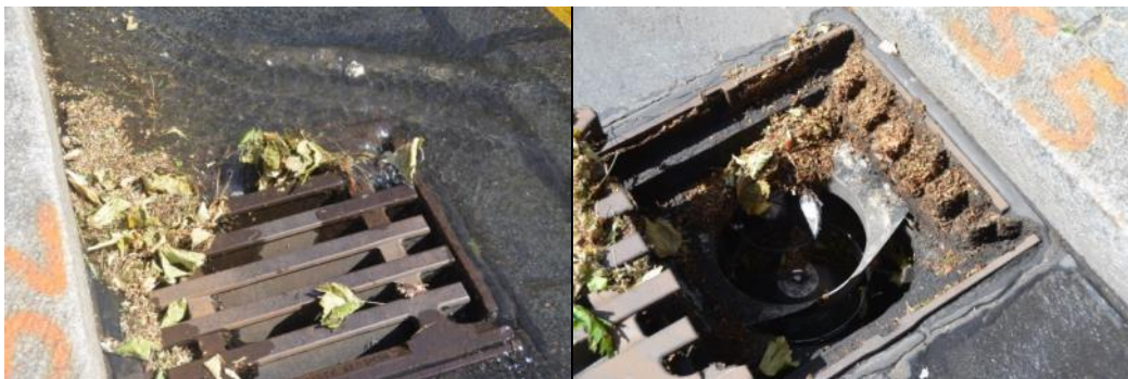
Abbildung 4.3: Blüteneintrag Gitterrost und Straßenablauf
