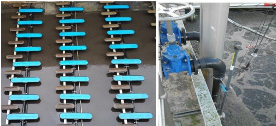
Abbildung 9: links: Anordnung der Rohgas-Belüfterstränge; rechts: Belüfterharken
