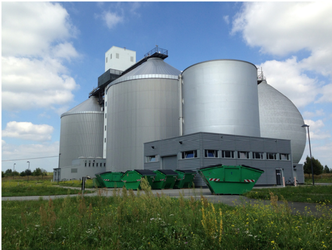
Abbildung 11: AirPrex®-Anlage im Klärwerk Waßmannsdorf, Kabbe®
