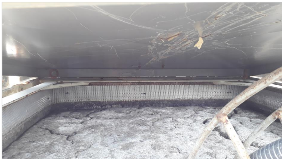
Abbildung 62: Bildung einer Schwimmschlammschicht im Siebkorb
