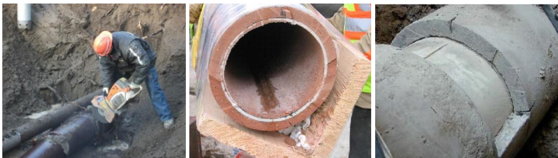
Abbildung 2: Entnahme von Proben aus Haltungsbereich aus offener Baugrube: links: Entnahme [12], Mitte: entnommenes Probenstück [13], rechts: Entnahme Halbschale [2]
